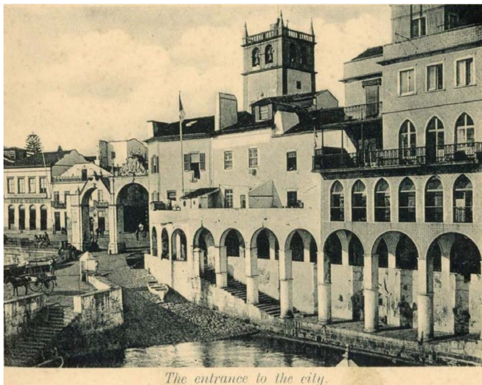
Figura 6 - Detalhe de um postal antigo editado pela “ Society for promoting the propagation about the Island of St Michael's ” (coleção de Rita Van Zeller), em que se pode ver, encostada às portas da cidade, a fachada posterior do edifício da Fig. 4, e, à direita, uma fachada de vãos neogóticos totalmente azulejada, a qual ainda subsiste, embora sem os pilares dos arcos visíveis, por via do aterro que ali foi feito.
