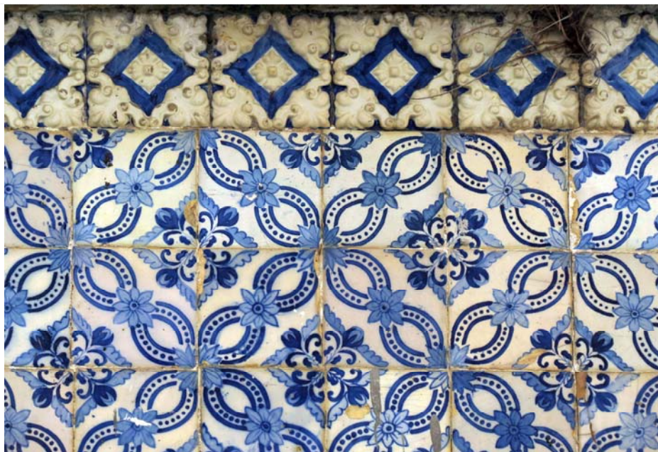
Figuras 9 e 10 - Fachada da Travessa do Aterro e detalhes do padrão e da cercadura (fotos do autor).
